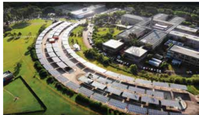
Figura 3 – Vista aérea 2 da usina FV-BIO.
