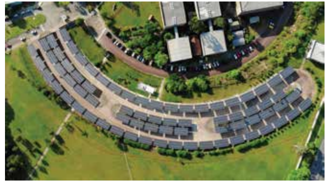
Figura 2 – Vista aérea da usina FV-BIO.
